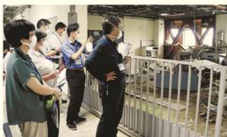
旧気仙沼向洋高の遺構を視察する教員ら—宮城県気仙沼市の東日本大震災遺構・伝承館で
