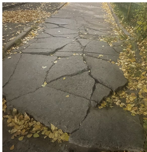
図5. ひび割れ、隆起した舗装道路
